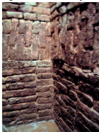
Afbeelding 14: rollaag en L-vormige poer in het middeleeuwse werk van de beerkelder.
