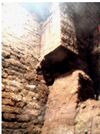
Afbeelding 14: rollaag en L-vormige poer in het middeleeuwse werk van de beerkelder.
